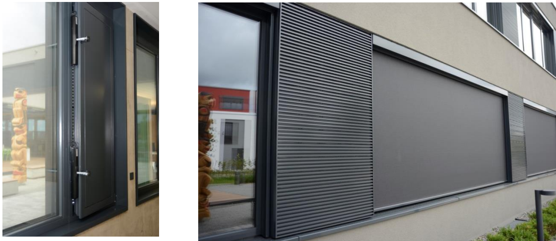
Abbildung 96: transparenter Sonnenschutz und Lüftungklappen von innen und außen 76
