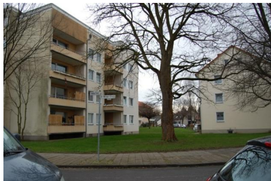
Beispielhaftes Mehrfamilienhaus mit Handlungsbedarf zur Sanierung der Fassaden
