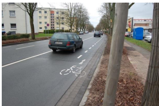
Reimerdeskamp: Schutzstreifen und für den Radverkehr freigegebener Fußweg
