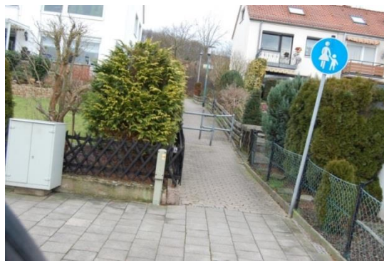
Umlaufsperrung als Barriere (Leharweg)
