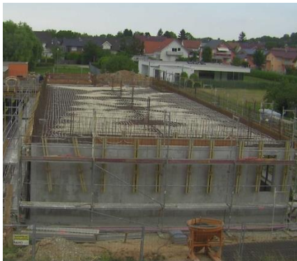
Abbildung 94: Rohrsystem zur Aktivierung der Bauteilmasse 74
