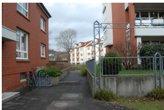
Fehlender abgesenkter Bordsteine (nördlich Schlüterskamp)
