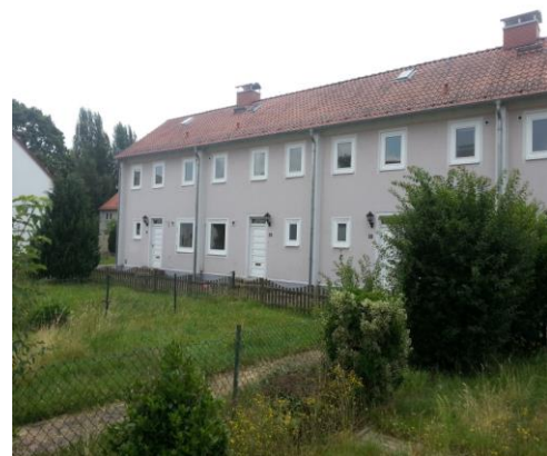
Abbildung 99: Ansicht Nord Haydnweg 11-17
