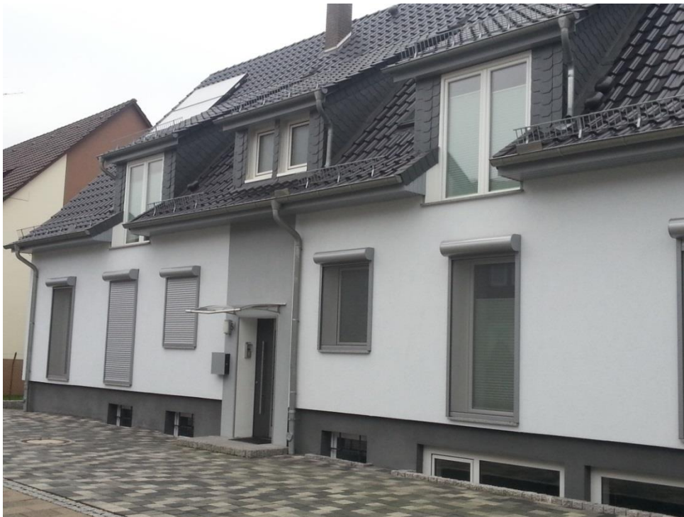
Abbildung 74: Grundsaniertes Reihenhause im Quartier
