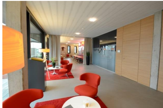
Abbildung 93: Ansicht der aktiven Kühl- und Heizdecke (Sichtbeton) von innen nach Fertigstellung
