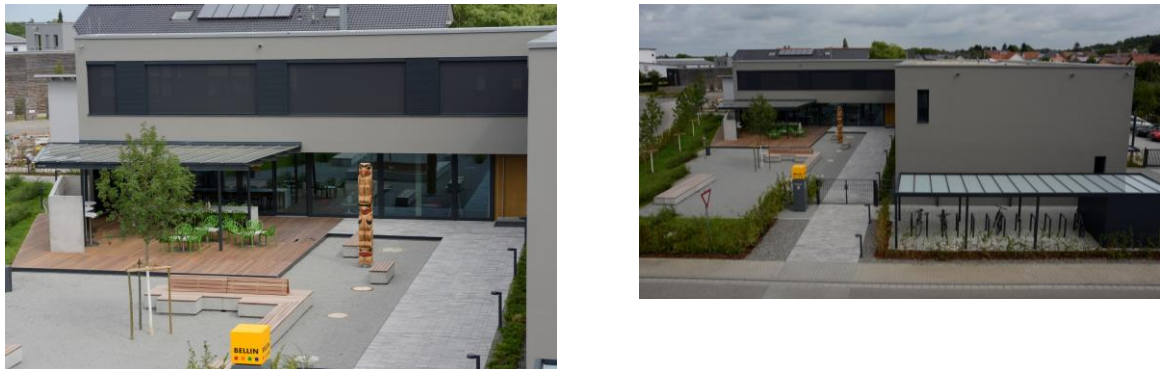
Abbildung 97: Gesamtansicht des Gebäudes 77
