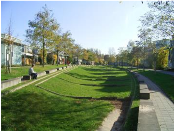
Abbildung 98: Rigole als Gestaltungselement 78
