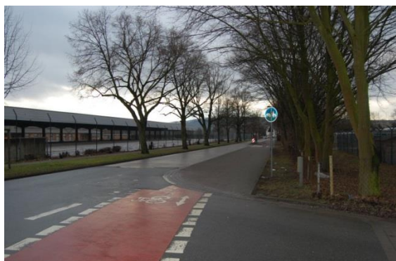
Abgesenkte Bordsteine (hier: Bertholdsweg)
