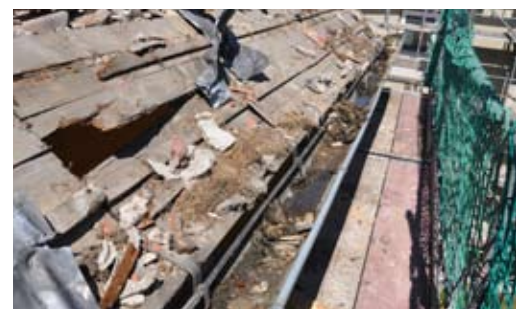
Abgedecktes Dach mit Nistmaterial
