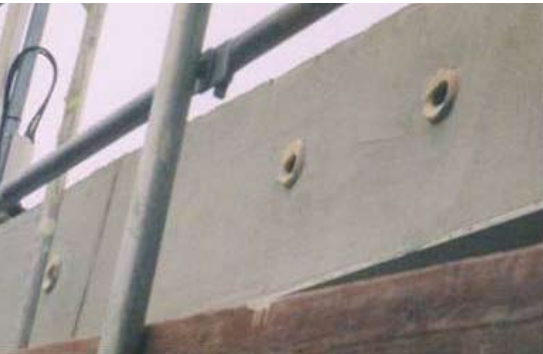
Einbausteine im Kaltdach
